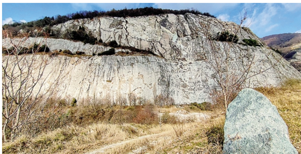
La vecchia cava dell'Alpetto: 80mila metri quadri verranno ricoperti da pannelli fotovoltaici MENEZZO
